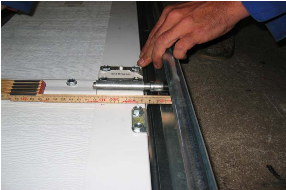
Bilde 1: Avstand mellom innvendig veggskinne og port element ca. 35mm.
